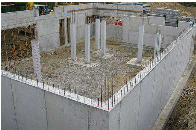
Construcció amb formigó. Font: merle.es
