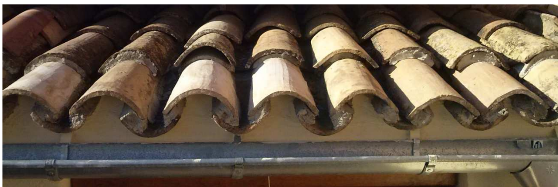
Canonades teulada recollida aigua pluvial. Font: foto pròpia.
