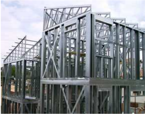
Estructura d'acer galvanitzat. Font: casasligeras.com
