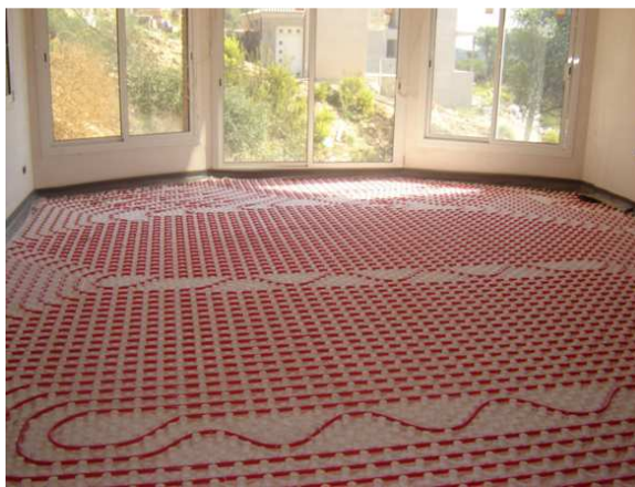
Instal·lació terra radiant. Font: inproinstalations.com
