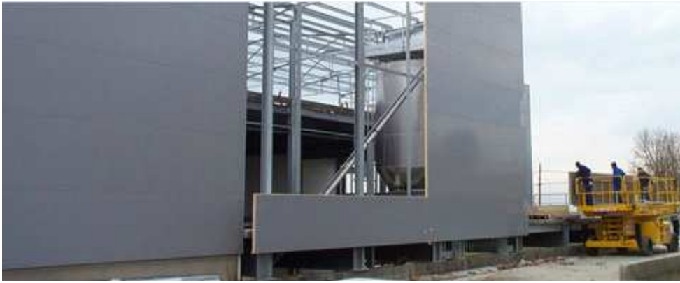
Estructura metàl·lica lleugera amb panell sandvitx de poliuretà. Font: taver.es
