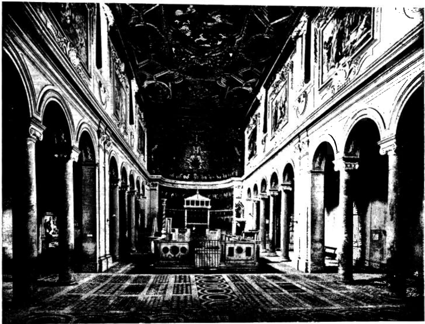
Fig. 9. — Interior de la basilica en el seu estat actual després de les reformes de Clement XI.
