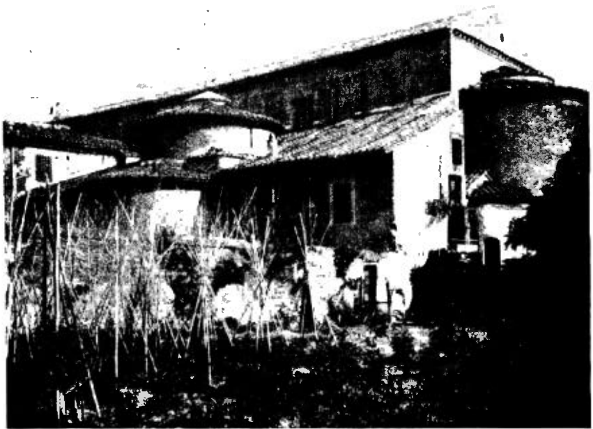
Fig. 8. — Exterior de la construcció. La caixa de la nau dreta ve amagada per la capella de SS. Ciril i Metodi i per un petit edifici que hi està adossat.
