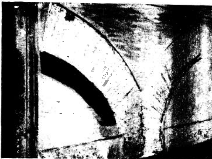
Fig. 5. — Dues arcades descobertes del mur de la nau central de la basilica soterrada. Aquest mur fou aprofitat, tot sencer, per tancar la nau dreta de la basilica del s. XII. Aquelles es veuen actualment sortint del paviment i trencades per la porta de la sagristia.
