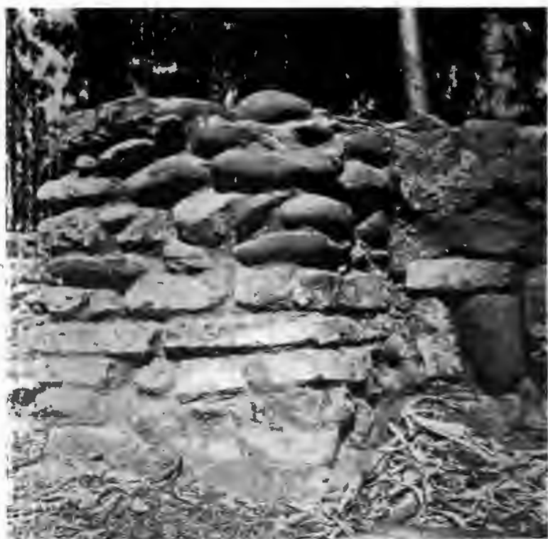
Muro de mampostería de la zona bautismal de San Pedro de Alcántara
